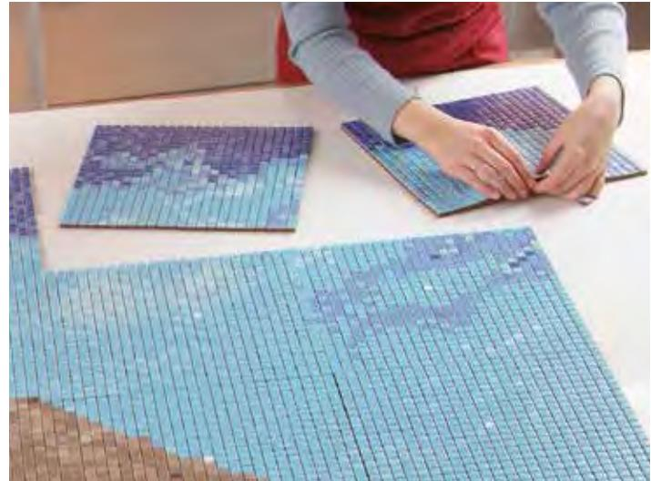
Die Mosaikblätter sollten nach dem Montageplan trocken auf dem Boden gelegt werden, um die korrekte Zusammensetzung nach der Zeichnung zu prüfen.
